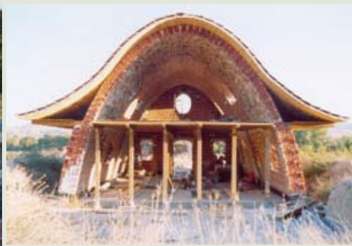
La estructura en bóveda con curva catenaria es una estructura muy resistente, pues es el arco más mecánico, ya que la línea de presiones sigue exactamente la forma del mismo.
