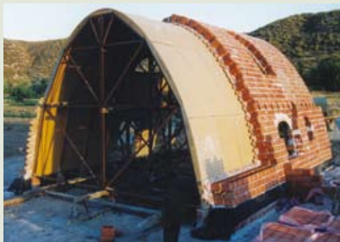
La estructura en bóveda con curva catenaria es una estructura muy resistente, pues es el arco más mecánico, ya que la línea de presiones sigue exactamente la forma del mismo.
